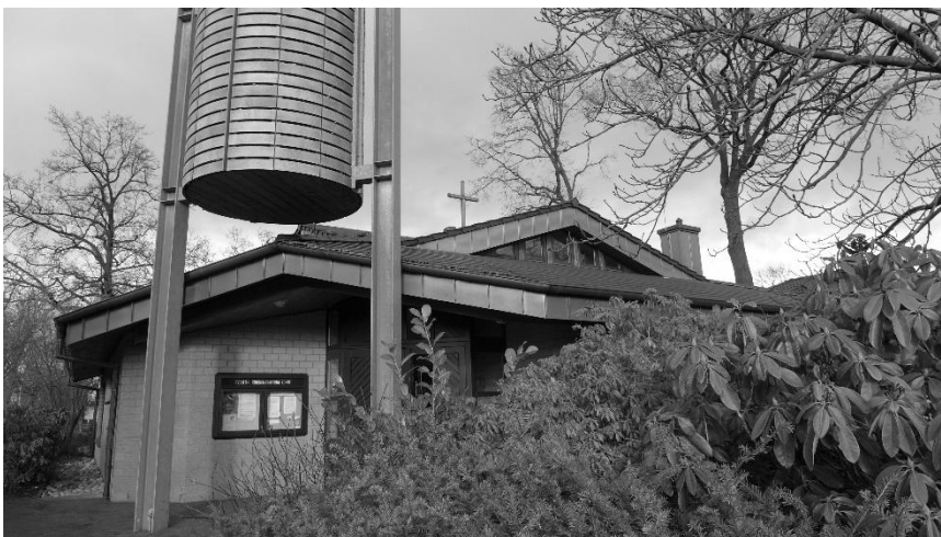
Das Kirchenzentrum in Lohne wird momentan renoviert.
